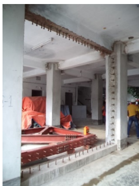
(d) Chemical anchor at beam and column
