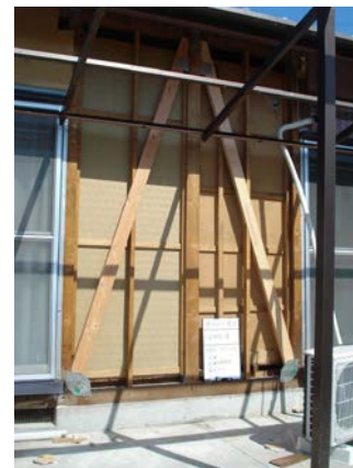
Fig 4— Seismic retrofit, Example 2
